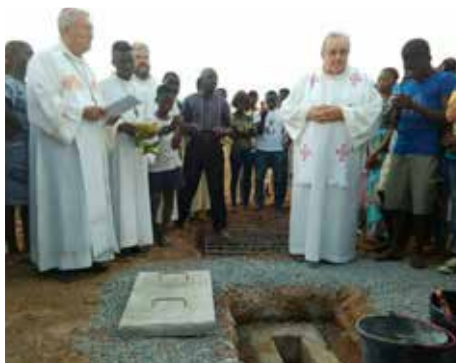
La posa della prima pietra della nuova chiesa
